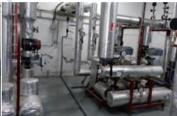
Obrázek 13 - 2x výměník pro ohřev topné vody
